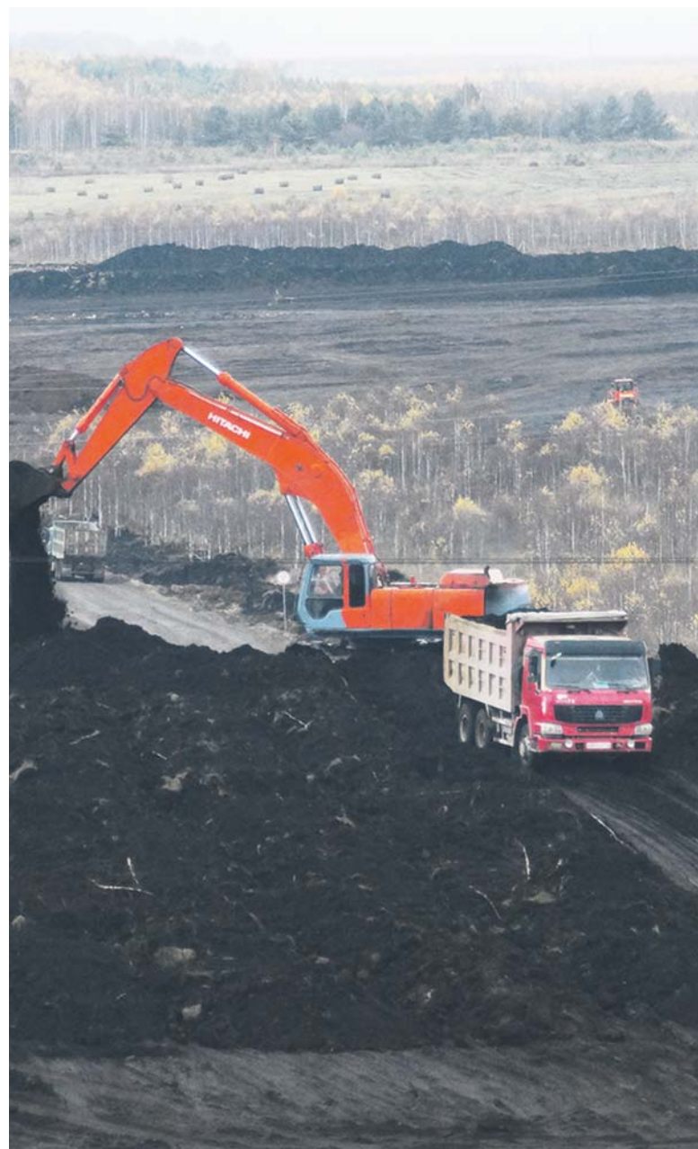
Плодородный слой грунта тщательно снимается и складывается
