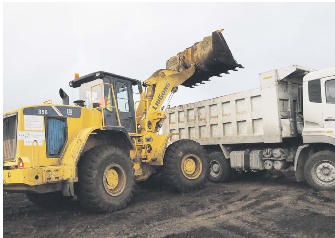
Самосвалы снуют по площадкам, как муравьи, работы идут круглосуточно
